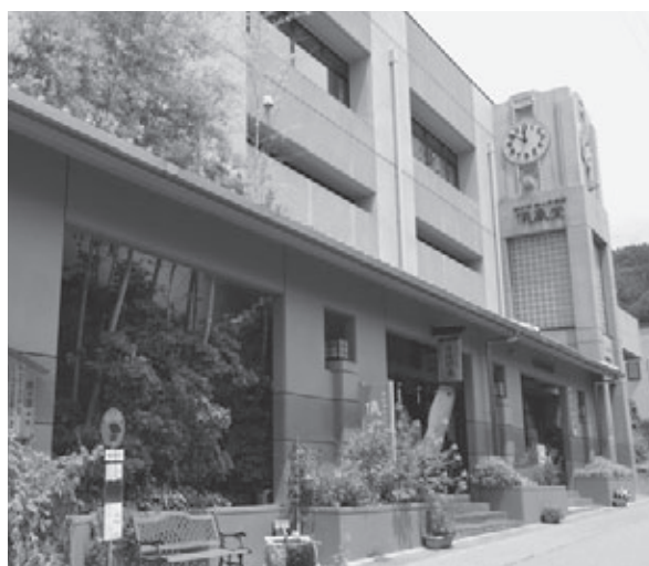
改修予定の儀象堂
